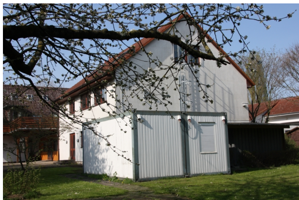
Hinterhaus mit genehmigten Container
